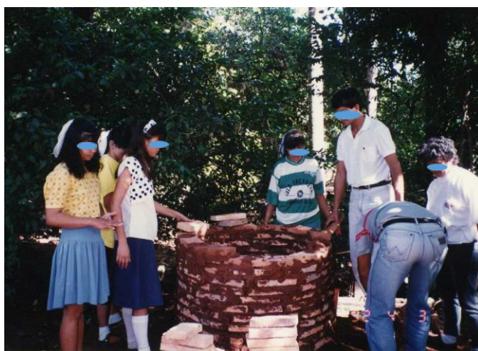
図 4-12 教員養成校学生の陶芸用焼成窯の作成実習
