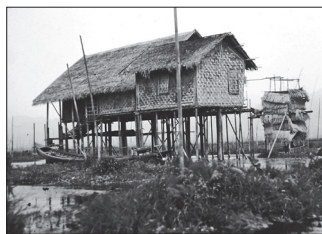
図5-22 ミャンマーのインレー湖の民家 どの民家も、雨季の湖の水位を想定して高床式の建築となっている。雨季になると舟は玄関と直結する。民家は雨季に合わせて造られている。
