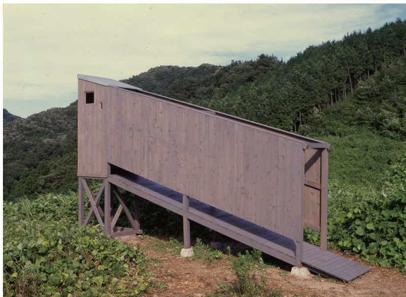
332.5×95.5×600cm (窓8) 木造+コンクリート基礎+ガルバリウム鋼板
