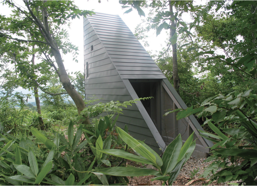
2003年 410×120×370cm（窓5） コンクリート基礎、木材、ガルバリウム鋼板
