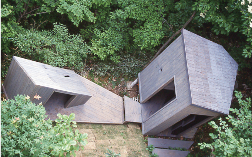
345×216×176cm (窓4)、225×200×108cm (窓5)、2棟回遊式 木造+コンクリート基礎
