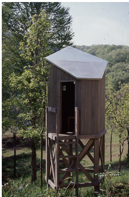
440×170×145cm（窓8） 木造・コンクリート基礎、ガルバリウム鋼板
