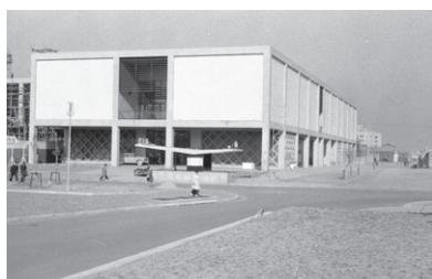
図4 愛知県文化会館美術館の外観 1956年
